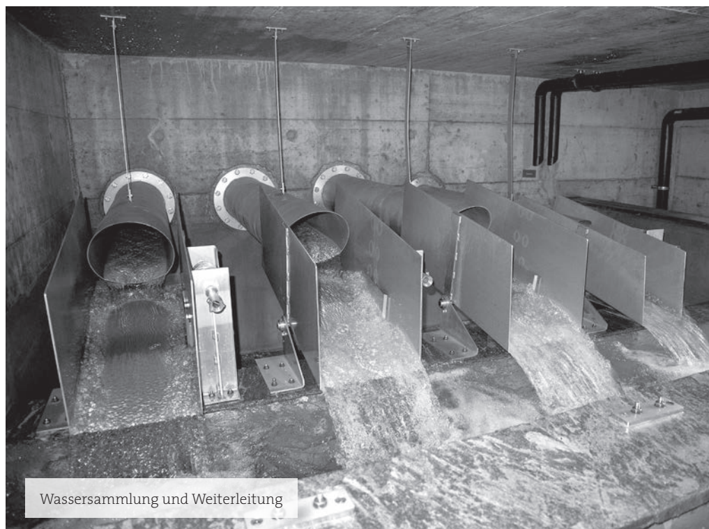
Einstieg in den Brunnenschacht
