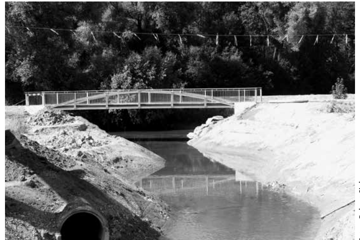
Die neue Fussgängerbrücke über den offen gelegten Lehenkanal im Mündungsbereich
