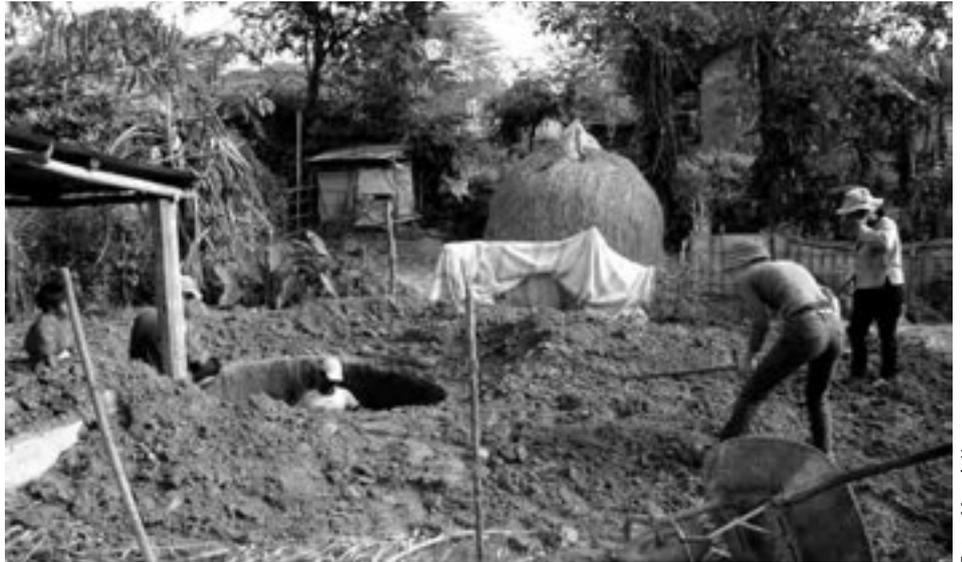
Mehr als 2 m tief, 2 m Durchmesser und oben einen «Kragen» wie bei einer Blumenvase: das Ausheben der Grube ist Knochenarbeit.
