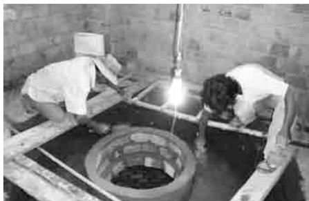
Die Grube wird mit Backsteinen ausgekleidet und mit Zement luftdicht abgeschlossen.
