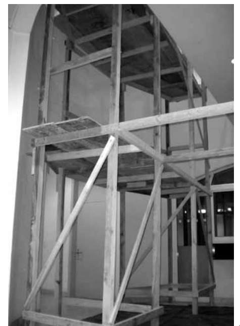
Ungewohnte Art von Arbeitsgerüst.
